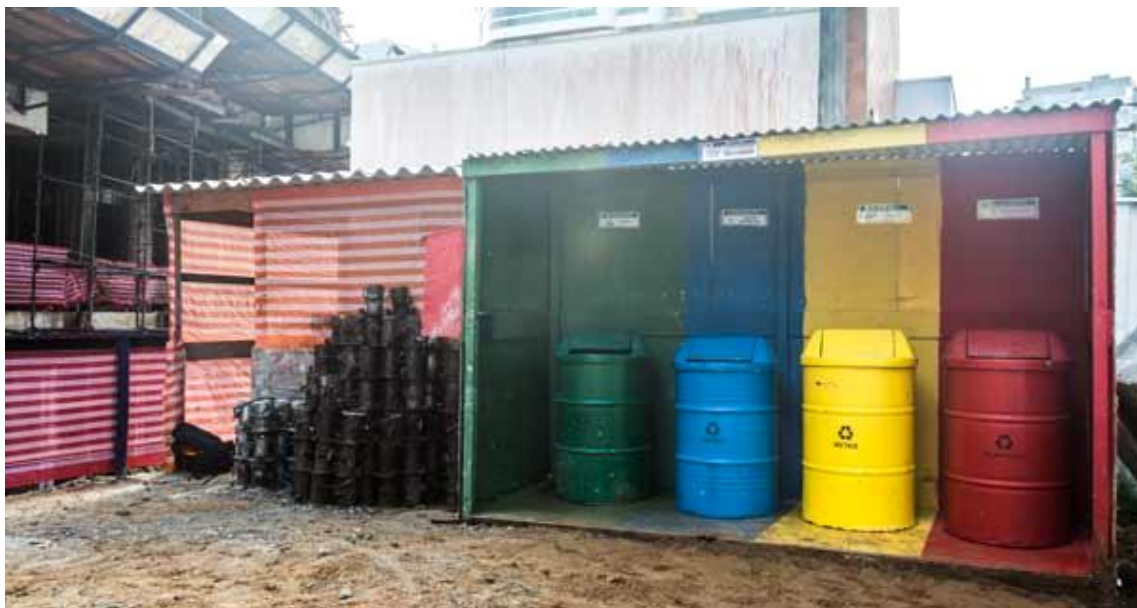
Figura 96 - Coleta seletiva em canteiro de obras. Fonte: ArqBrasil.
