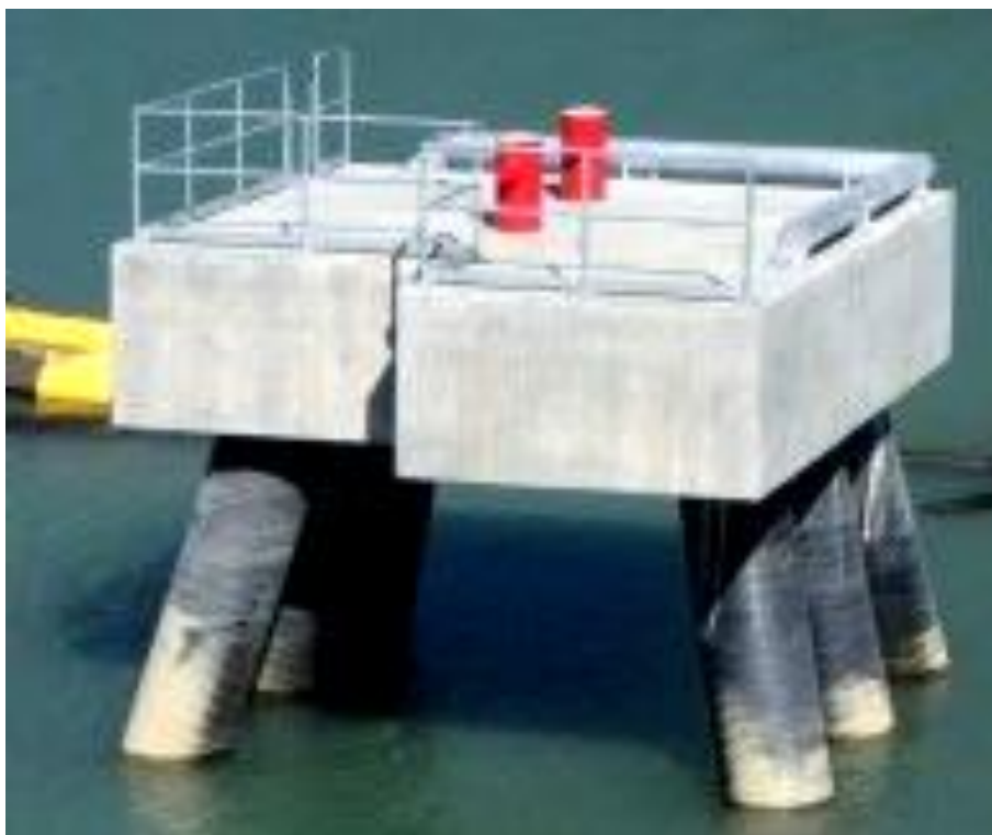
Figura 62 - Exemplo de Píer de atracação em dolphins. Fonte: Squamish Terminals.
