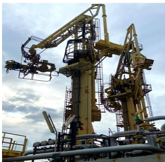
Figura 63 - Exemplo de braço de transferência de GNC. Fonte: Fabricante ENCO WHEATON.
