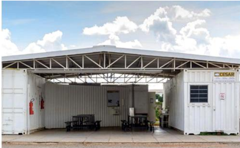
Figura 89 - Área interior, refeitório em contêineres.
