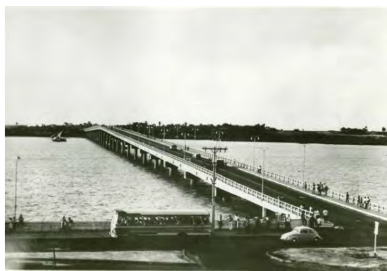
Foto 2 - Ponte Governador José Sarney, Rio Anil. Fonte: IBGE Cidades, [19-].
