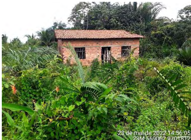
Foto 7 - Residência sem moradores, dentro da comunidade de Embaubal. Fonte: MRS (2022).
