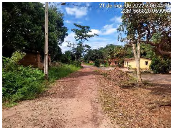
Foto 24 - Via de acesso da comunidade Amapá. Fonte: MRS (2022).
