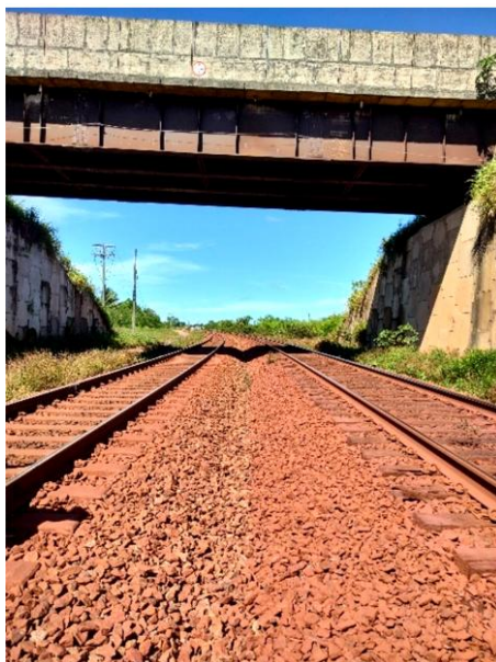
Figura 2-5 - Trecho da EFC na região de interesse. Fonte: GRAF (2024) sobre imagens de satélite disponíveis no aplicativo Google Earth.
